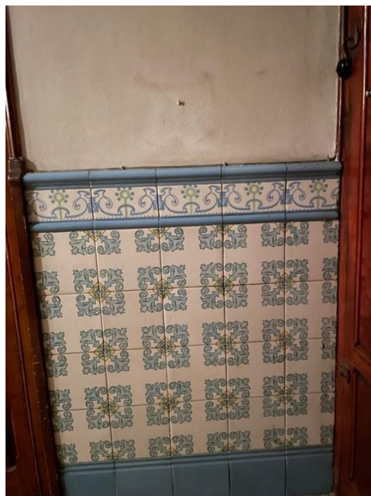
Plafonat de l'arrambador de ceràmica
