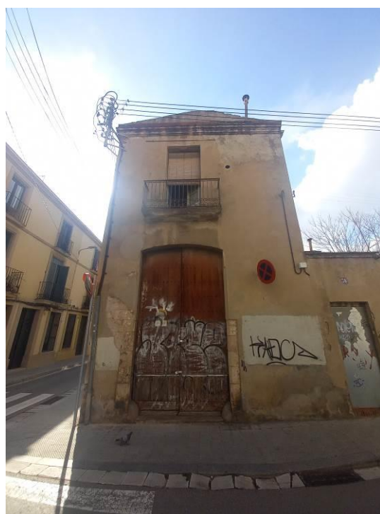
Façana del carrer Sant Pau amb l'esvelta portalada d'accés.
