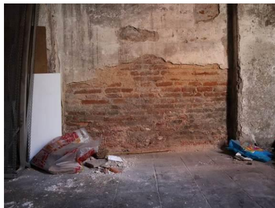
Detall de la tècnica constructiva de les estructures muraries de tancament de la nau, fetes de maó massís.
