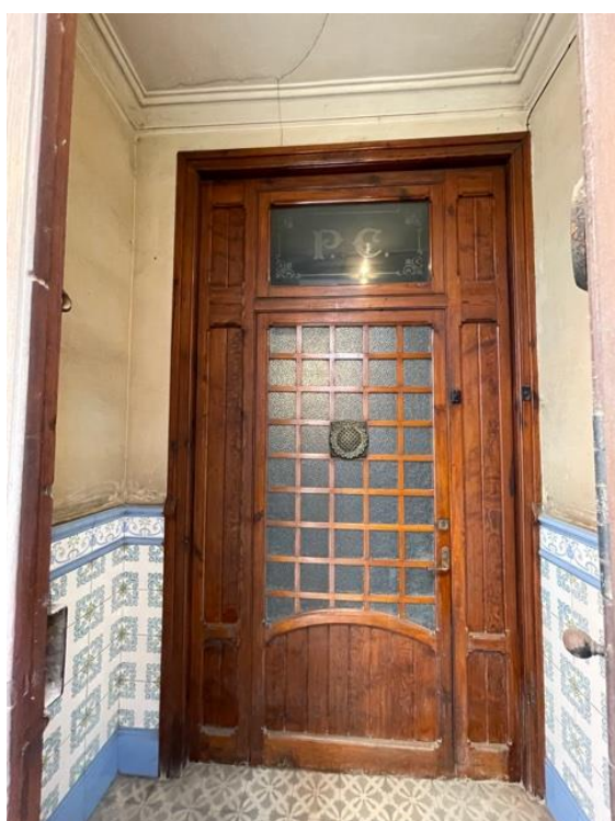
Porta principal de fusta amb el full central amb casetons de vidre gravat.
