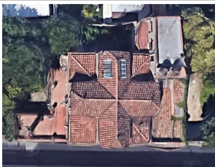
Vista aèria del conjunt de la coberta de l'edifici principal on es posa manifest la singular rellevància que assoleix la solució arquitectònica adoptada.
